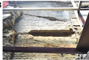
図6 延平路57号 屋根の痕跡
