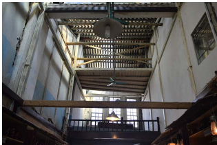
図5 延平路57号 内部空間
