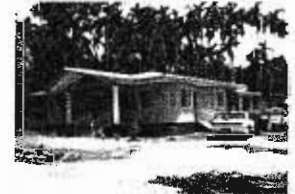
写真-46 基礎を取り壊して新築された住宅
