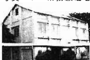
写真-9 工場・発電室
