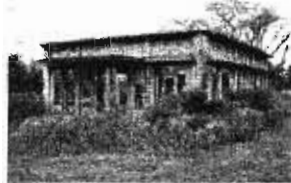
写真-21 工場・事務所
