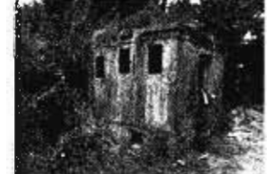
写真-4 公衆トイレ
