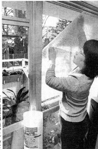
断熱シートをガラス窓に貼ることで結露が防止できる
